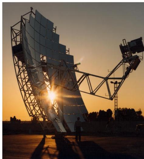
Il vero problema è costituito dal costo piuttosto elevato (300-400 \$/m<sup>2</sup>) e dalla complessa tecnologia e manutenzione: gli specchi vanno puliti ed orientati e i congegni di puntamento sono delicati. In figura 6 si vede una fornace solare con concentratore parabolico.
