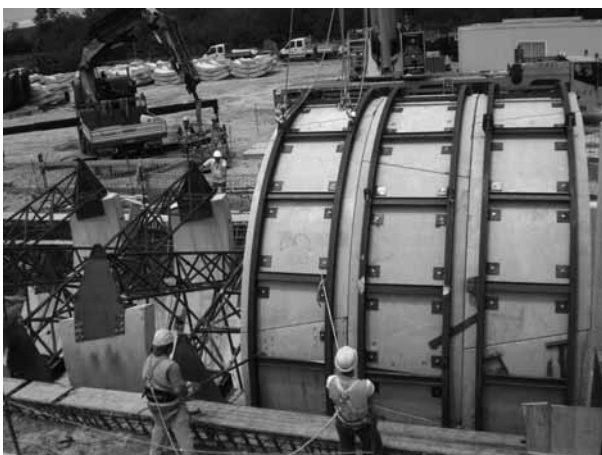
Fig. 2 - Montelibretti (RM) - Galleria in costruzione
