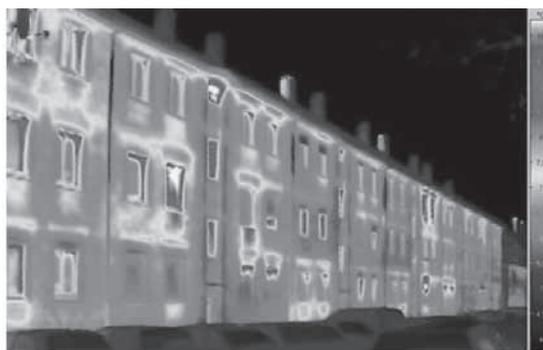
Fig. 16 (a) Schema di teleriscaldamento. (b) Termografia a raggi infrarossi: nelle zone più chiare si perde calore.
