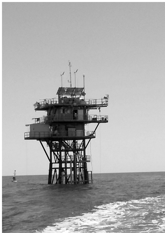
Fig. 4. Piattaforma Oceanografica “Acqua Alta” del CNR, situata nel Mare Adriatico Settentrionale. Misura diversi parametri oceanografici consultabili in tempo reale http://www.ismar.cnr.it/infrastrutture/piattaforma-acqua-alta .
